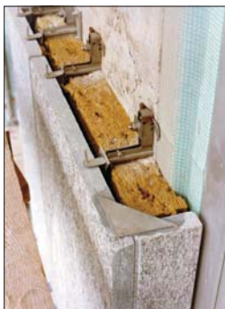
Рис.1. Крепления для фасадов из натурального камня
