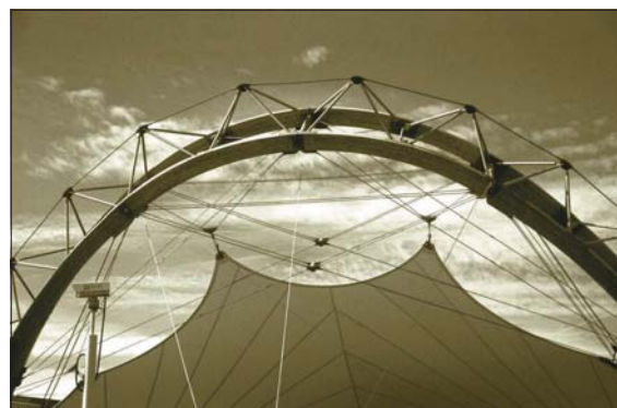
Рис. 5. Несущая конструкция со стяжками Detan
